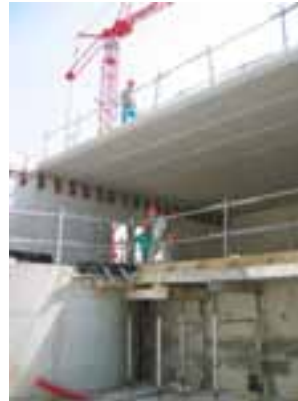
• Pose du plancher
