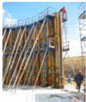
• Coffrage et coulage des voiles
