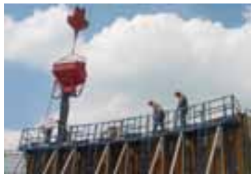
• Coffrage et coulage des voiles
