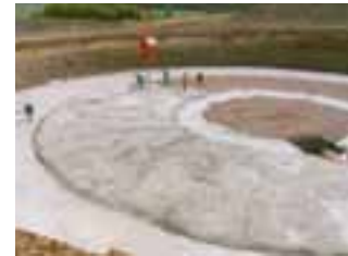
• Mise en place de béton de propreté
