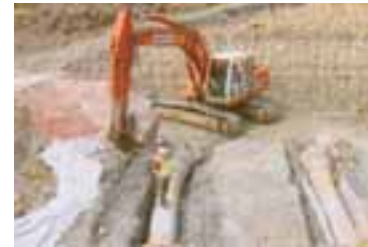
• Pose du réseau
