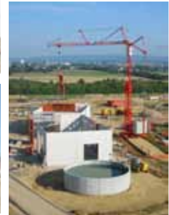
• Coffrage et coulage des voiles
