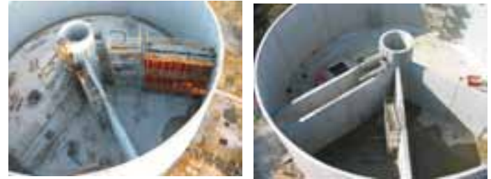
• Réalisation des voiles
