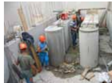
• Montage du dégrilleur
