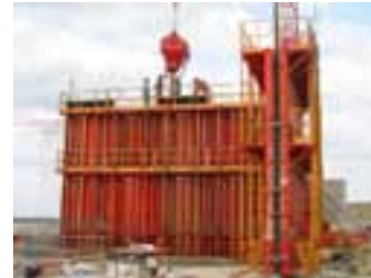
• Coffrage et coulage des voiles
