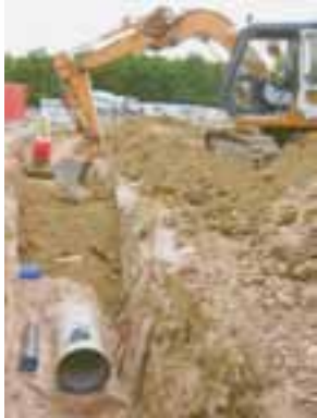
• Pose du réseau entre PRE-BAE
