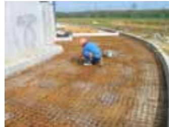
• Bétonnage voirie d'accès
