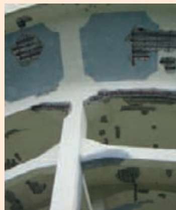
CHUTE DE BÉTON
