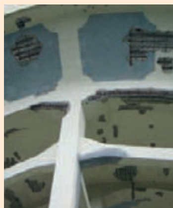
CHUTE DE BÉTON
